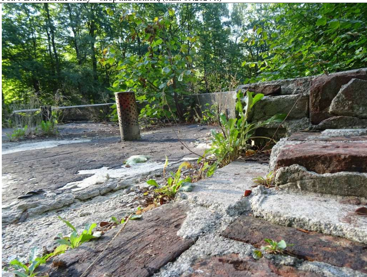
Fot. 10 Zwieńczenie wieży – strop nad komorą (stan: 09.2024 r.)
