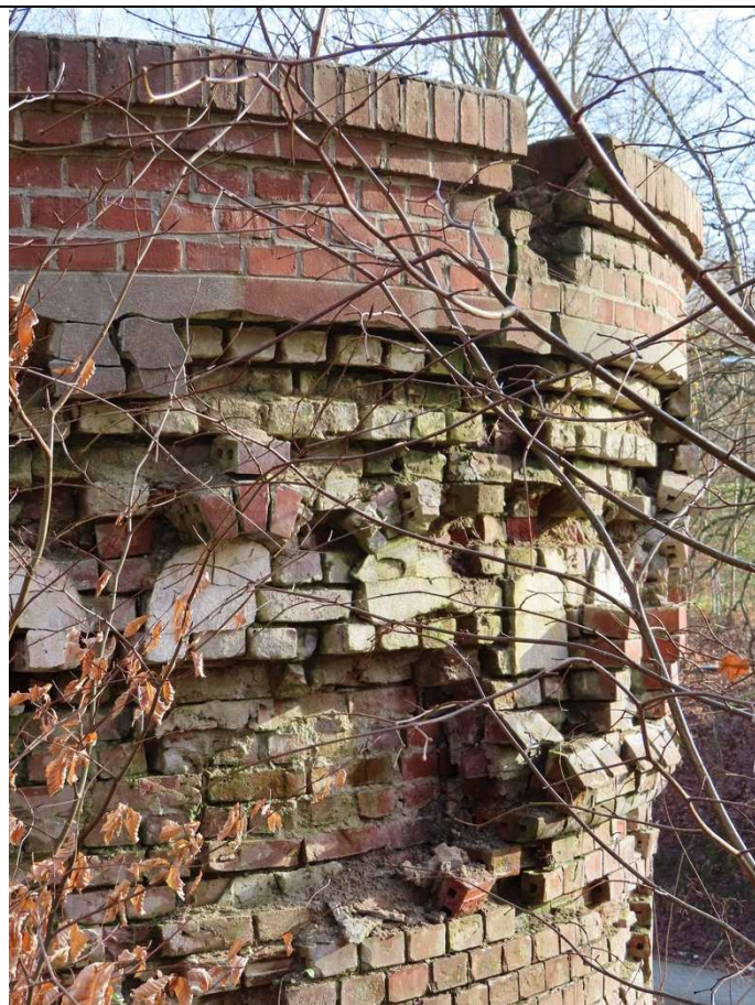
Fot. 6 Fragment zwieńczenia muru (stan: 01.2025 r.)
