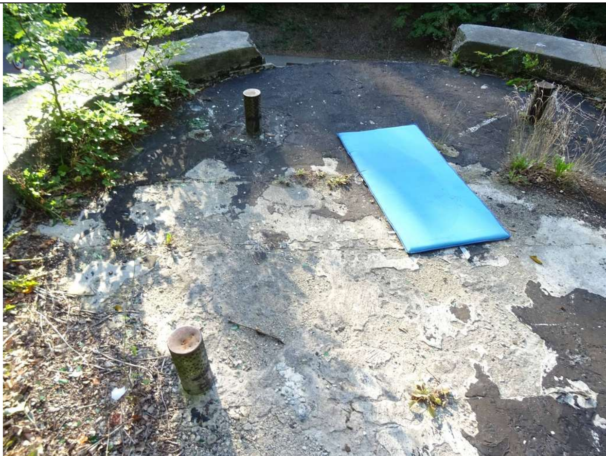
Fot. 9 Zwieńczenie wieży – strop nad komorą (stan: 09.2024 r.)
