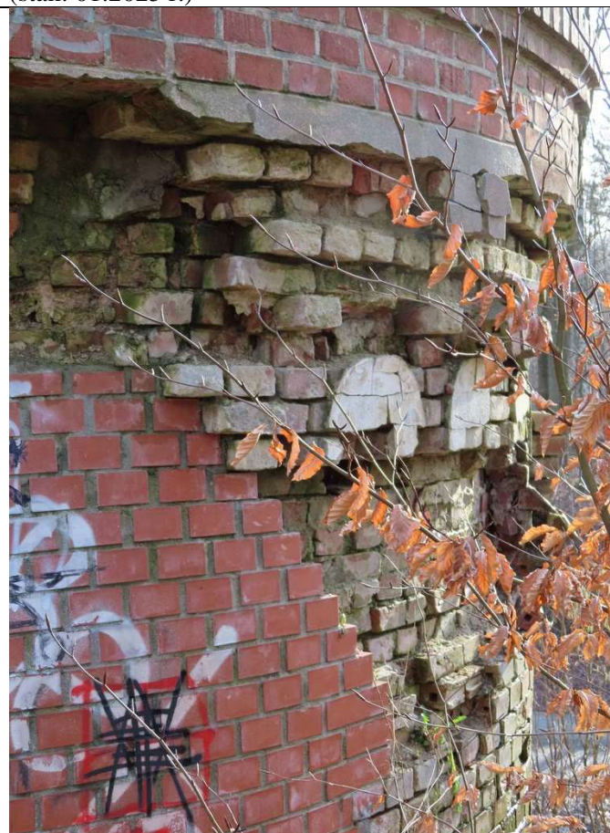
Fot. 7 Fragment zwieńczenia muru (stan: 01.2025 r.)
