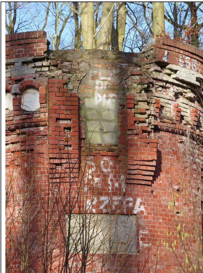
Fot. 5 Fragment elewacji południowo-wschodniej (stan: 01.2025 r.)
