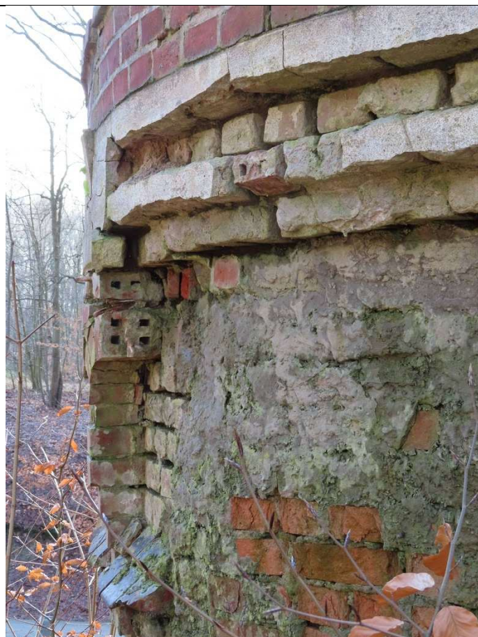
Fot. 8 Fragment zwieńczenia muru (stan: 01.2025 r.)
