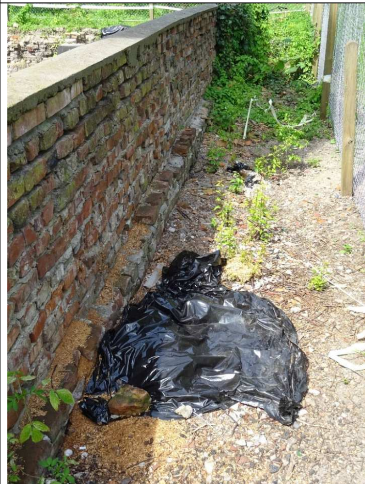
Fot. 10 Narożnik muru C, widok z poziomu nasypu za murem w kierunku odcina C-D i D-E. Widoczny fragment uszkodzonego muru i betonowej nakrywy muru oraz roślinności niskiej porastającej mur.
