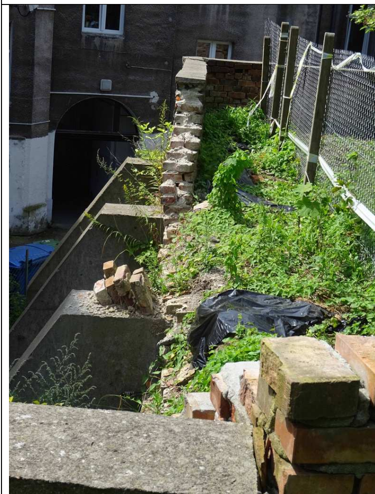
Fot. 9 Odcinek muru B-C. Korona zniszczonego muru, widoczna roślinność niska porastająca mur.
