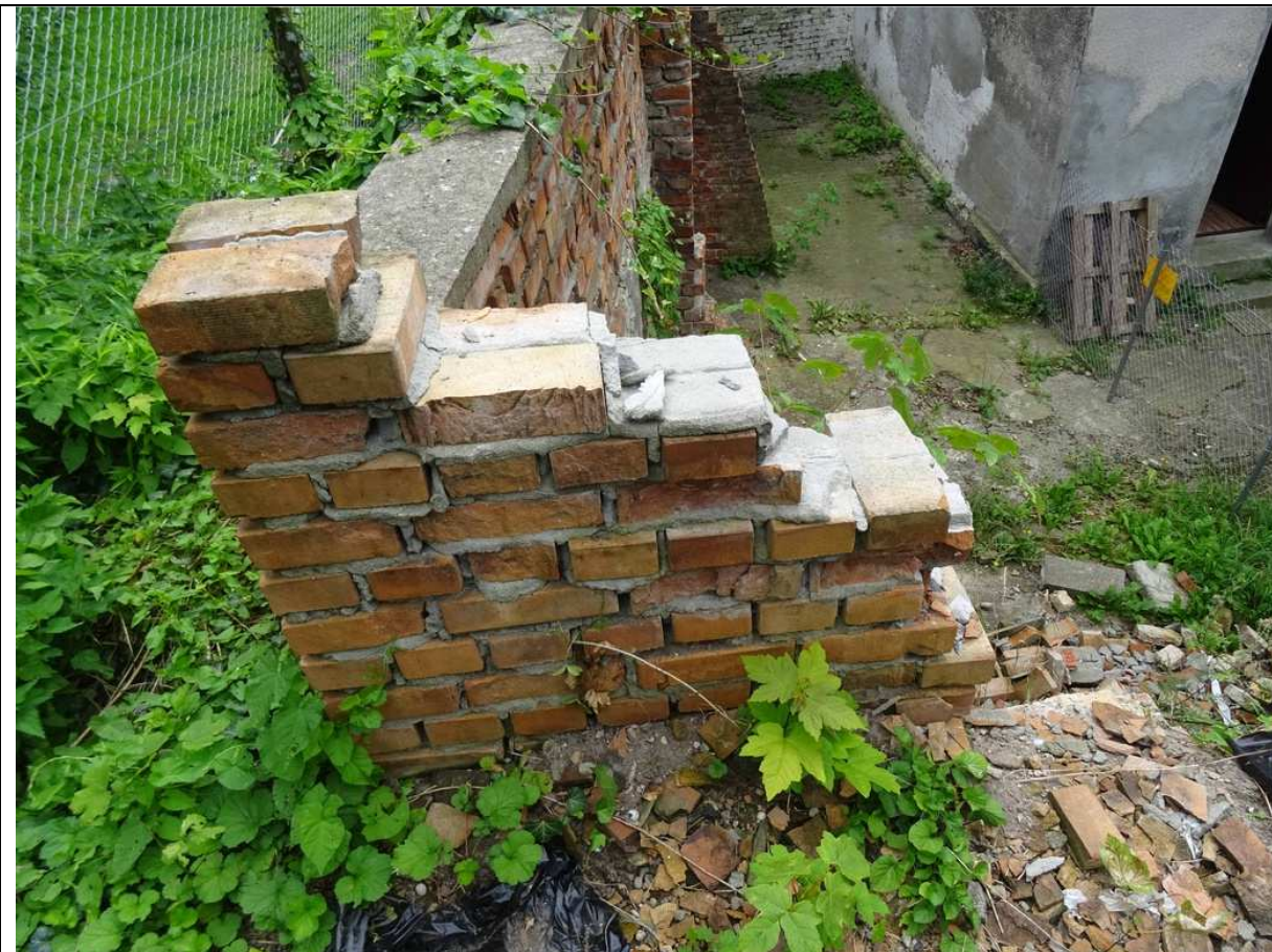
Fot. 10 Narożnik muru C, widok z poziomu nasypu za murem w kierunku odcina C-D i D-E. Widoczny fragment uszkodzonego muru i betonowej nakrywy muru oraz roślinności niskiej porastającej mur.
